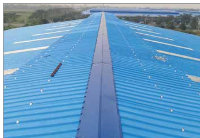
Công trình Nhà máy mạ luyện thép
