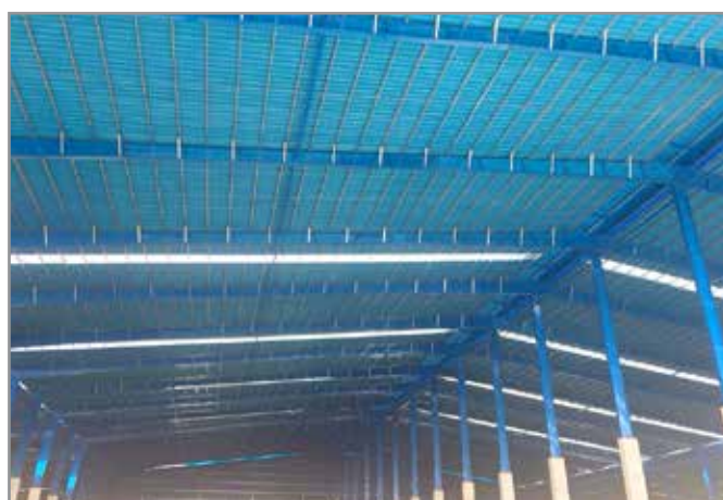
Công trình Nhà máy Phân bón
