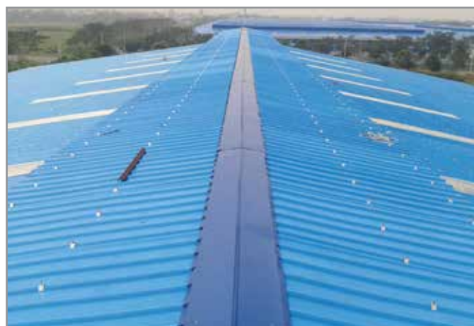
Công trình Nhà máy mạ luyện thép
