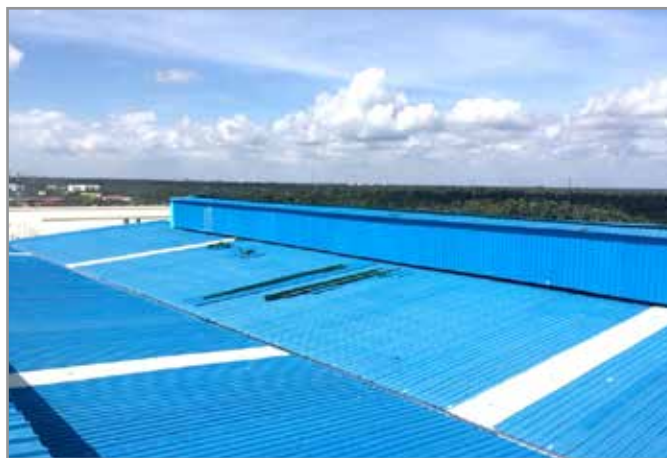
Công trình nhà máy gạch ceramic
