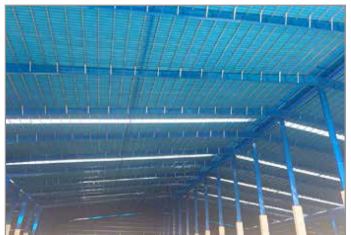
Công trình Nhà máy Phân bón
